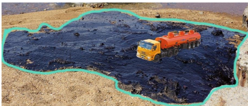
Рисунок 6 – Создание заграждения (голубым цветом) вокруг разлива при аварии автоцистерны
