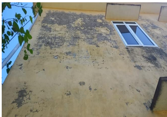
Рисунок 3 – Отслаивание краски из-за влажного воздуха
