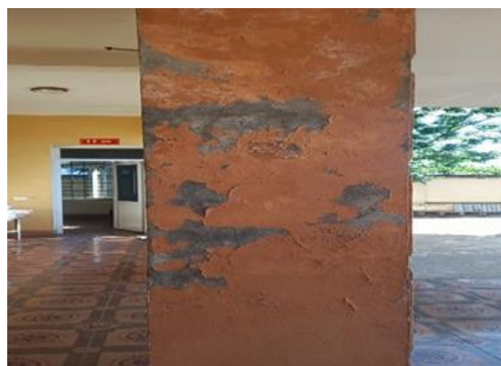
Рисунок 3 – Отслаивание краски из-за влажного воздуха
