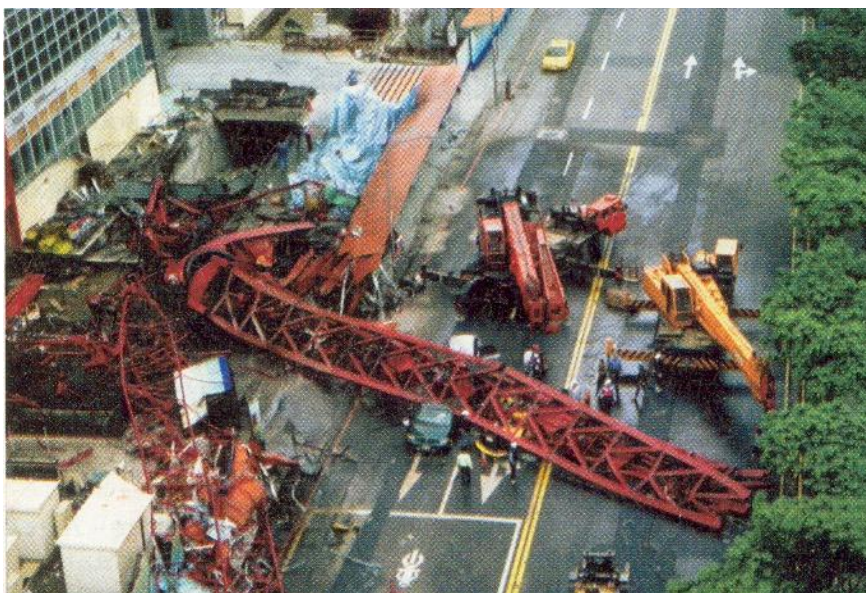
Рисунок 2 - Падение строительного крана на городскую магистраль при монтаже конструкций высотного здания
